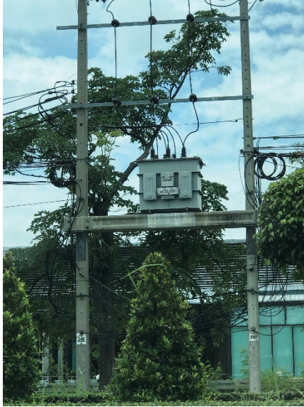
รูปที่ 7.3 หม้อแปลงการติดตั้งหม้อแปลงบนนั่งร้าน
