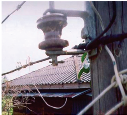
รูปที่ 3.8 ตัวอย่างสายหลุดจากลูกถ้วยเพราะการจับยึดไม่ดี
