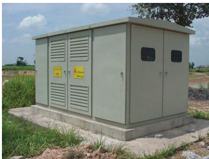
รูปที่ 7.4 ตัวอย่างการติดตั้งหม้อแปลงในเครื่องห่อหุ้ม
