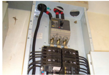
รูปที่ 3.4 การเดินสายที่เกิดความร้อนจากกระแสเหนี่ยวนำ (ตัวอย่างที่ผิด)
